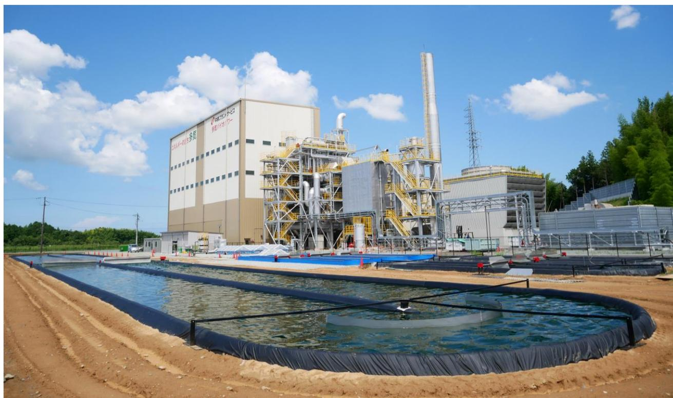
ユーグレナ社と小橋工業は、2014年9月に微細藻類の効率的かつ安定的な培養方法にかかる共同研究開発契約を締結し、水田造成技術を応用した燃料用微細藻類培養プールの建設方法の確立や、建設コスト低減に向けた共同研究を進めてきました。
